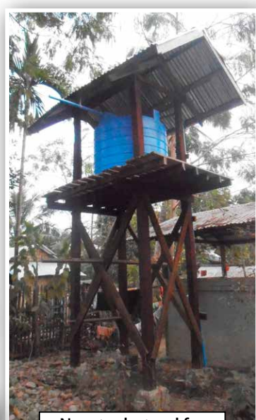
New tank stand for better water pressure 水圧を改良した水槽の新しいスタンド
